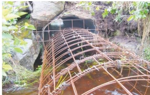
Figure 16. Grillage ajustable lors de l'installation d'un cylindre sur un ponceau endommagé.
